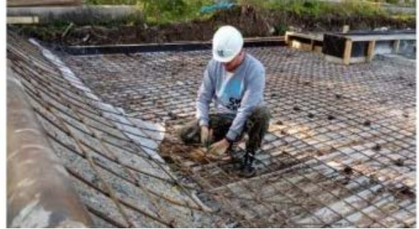
2 pav. Medinių klojinių montavimas.
