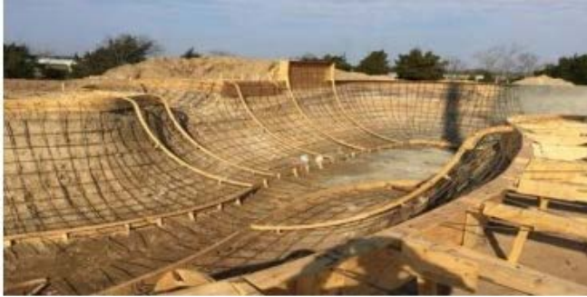
2 pav. Medinių klojinių montavimas.
