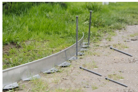
3 pav. Borto montavimo pavyzdys
