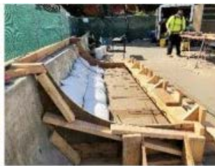
3 pav. Lenktos armatūros įrengimas.
