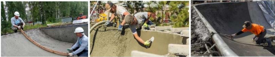
4 pav. Betoninio paviršiaus išlyginimas ir užtrynimas rankiniu būdu.
