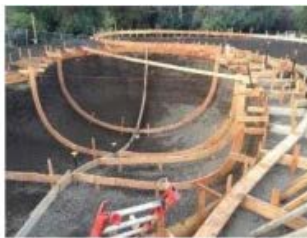
3 pav. Lenktos armatūros įrengimas.
